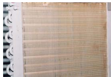
SPC (HLF 698) Gris Claro usado para revestir los tubos, cabezales, hojas las "U" en esta unidad
