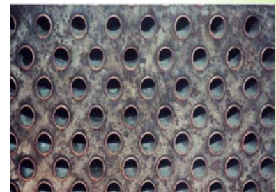
Antes del Tratamiento Cabezal de un Chiller limpiado con Arena a Presión y Revestido Con SPC (HLF815).Curado con Aire. Después del Tratamiento
