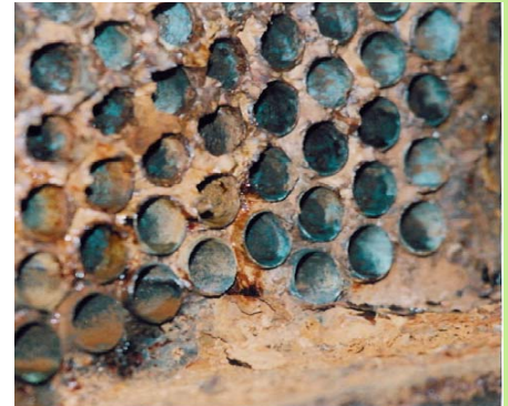
Antes del Tratamiento Cabezal de un Chiller limpiado con Arena a Presión y Revestido Con SPC (HLF815).Curado con Aire. Después del Tratamiento
