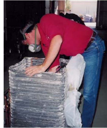
Contratista aplicando Sea Coast a un serpentín de púas finas, por Aspersión.
